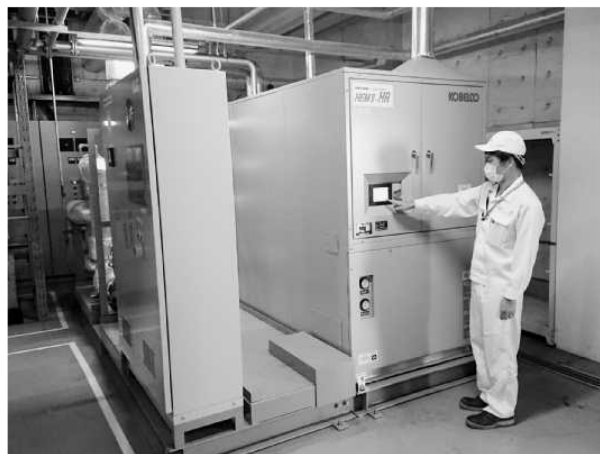
少ないエネルギーの投入で数倍の加熱が可能になり蒸気生成でのエネルギー低減を図っている
