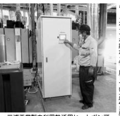
三浦工業製未利用熱活用ヒートポンプ「VH―15WW」。モニターで廃温水、ボイラ給水の温度や供給量などを確認できる
