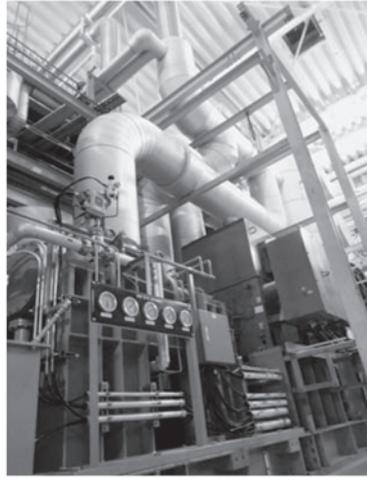
その後、煮沸用蒸気と蒸気を、スクラバー（排ガス浄化装置）を通して圧縮機に吸引する。低圧蒸気として回収し、工場内で利用できるように回収した余剰排気は、再び加熱利用できる圧力や温度になるまで昇圧・昇温する。の回収湯タンクが必要
