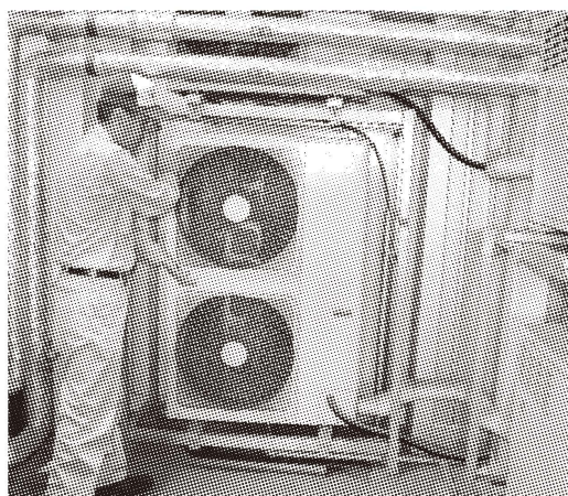
阿波工場に導入された循環加温ヒートポンプ
