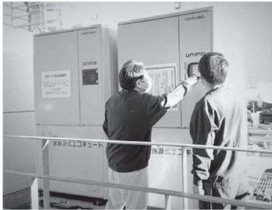
導入した熱交換システムの中核をなす水熱源ヒートポンプ
