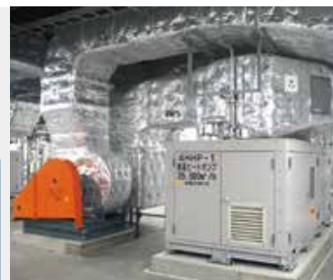
高温循環型熱風ヒートポンプ (↑外観と↓内部)
