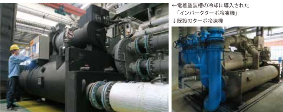
←電着塗装槽の冷却に導入された「インバータターボ冷凍機」 ↓既設のターボ冷凍機
