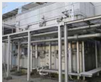
外調機(クリーンルームに取り込む外気を冷水と温水で温湿度調整する)
