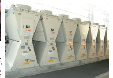
工場内省エネのため、空調用熱源も吸収式から電気式高効率ヒートポンプへ変更した。高効率ヒートポンプ（東芝キャリア）
