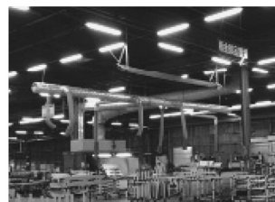
(D) エアハン +ダクトスポット空調
