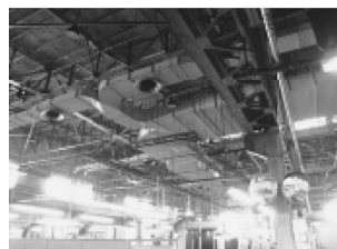
(C) エアハン +ダクト全体空調
