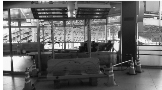
電気赤外線暖房機（駅コンコース待合室）
