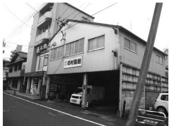
写真 1 田村製麺(有) 建物外観
