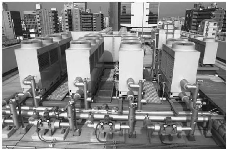
ヒートポンプチラーとビル用マルチエアコン室外ユニット、氷蓄熱槽は屋上に集約。給湯用の蓄熱槽は地下に設置されている
