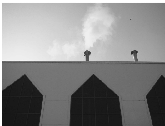
写真1 ビール工場の麦汁煮沸排蒸気（ラオス）
