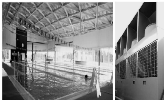
写真1 プール施設の空調・給湯システム
