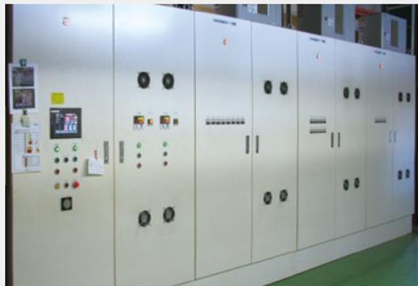
熱風に加え新たに赤外線を導入した省エネ型乾燥炉の制御盤
