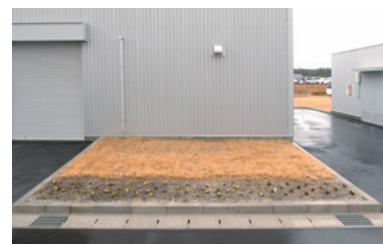
水蓄熱槽(地下)
