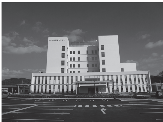
写真1 渋川医療センター外観
