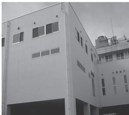
写真 1 健和会病院 5 号棟栄養科外観
