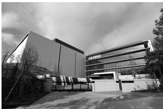
図 1 大型データセンタの外観
