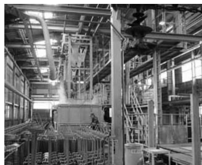
写真 1 カチオン自動電着塗装システム
