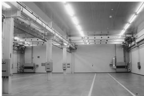
組立工場の内部
