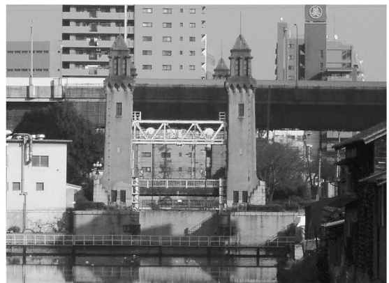
写真2 水位差を調整した水門の松重閘門
