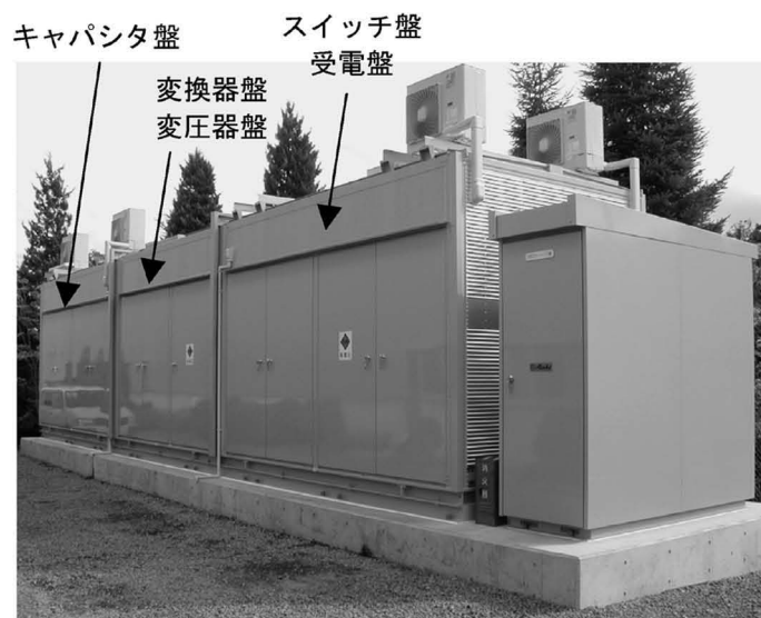
図 1 電気二重層キャパシタ式瞬低補償装置の外観
