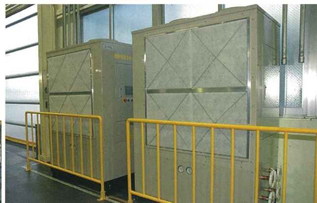
冷熱・温熱の両方を供給できる排熱回収型ヒートポンプ 《ゼネラルヒートポンプ工業》
